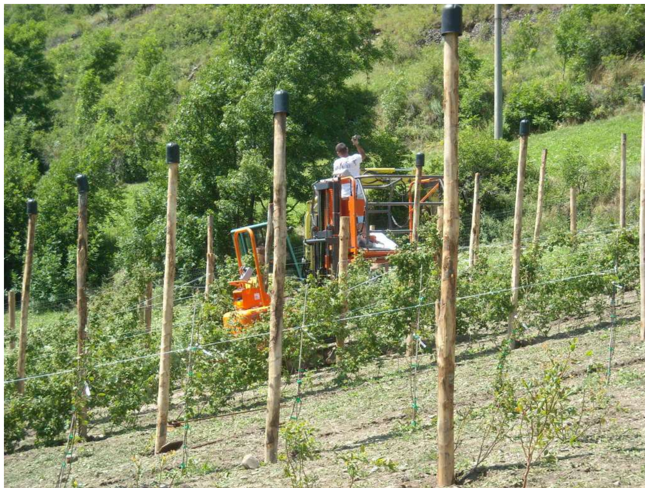
Avanzamento lavori struttura di copertura
