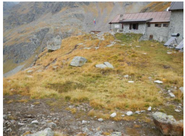
VISTA D'INSIEME DELL'IMPIANTO A FINE SETTEMBRE
