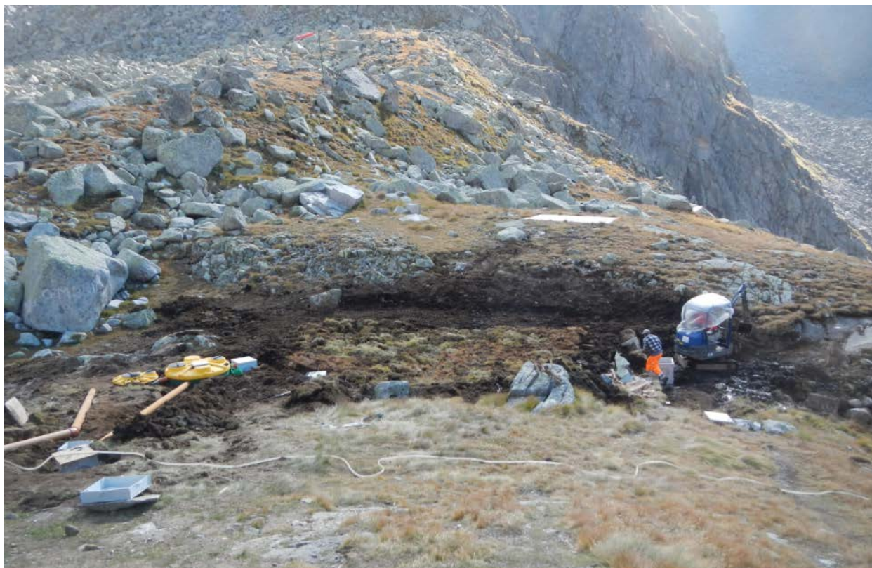
FIGURA 5 - IMPIANTO A SERVIZIO DEL RIFUGIO TONOLINI - SETTEMBRE 2014 (DURANTE I LAVORI)
