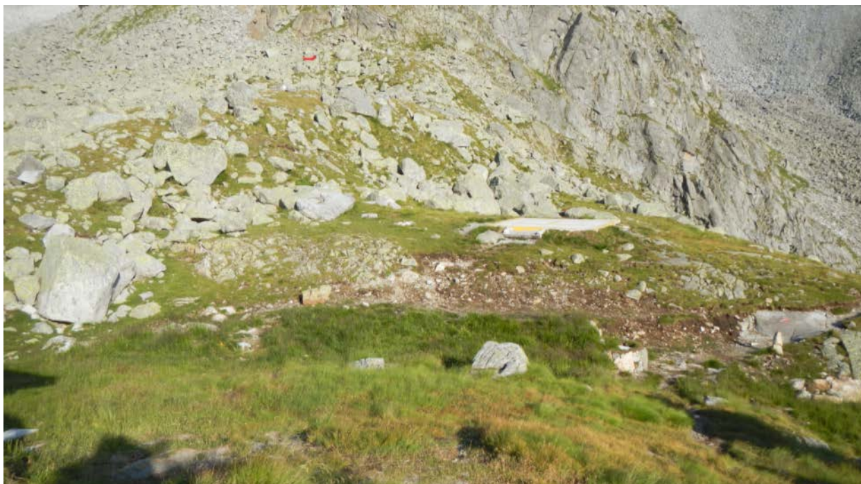
FIGURA 6 - IMPIANTO A SERVIZIO DEL RIFUGIO TONOLINI - LUGLIO 2017
