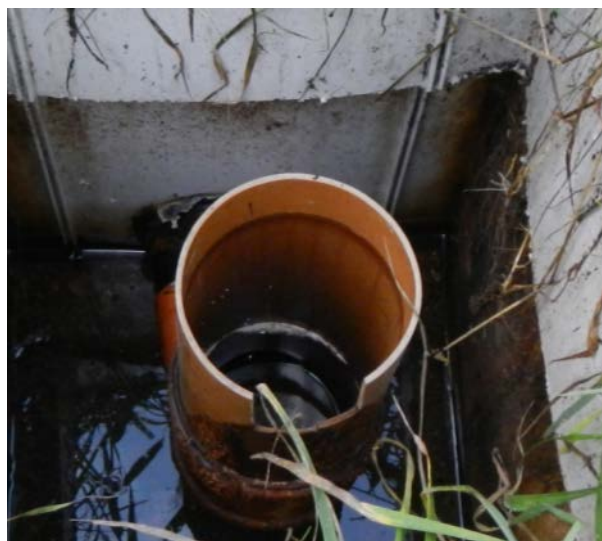
PARTICOLARE DEL SISTEMA DI REGOLAZIONE A VALLE DEL SECONDO LETTO
