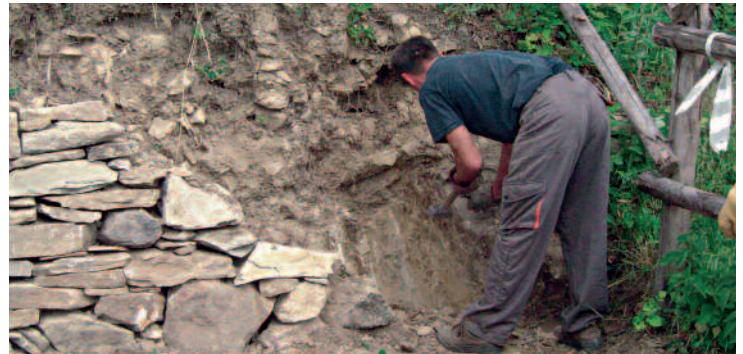
La preparazione del muro a scaletta per l'attacco di una nuova parte di muro o il raccordo con la roccia
