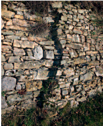
Esempi di non corretto attacco del muro recuperato al muro esistente poiché non viene mantenuto il filo verticale esterno: col tempo questo sfalsamento darà facilmente origine a cedimenti differenziati
