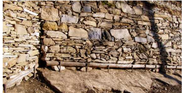
In presenza di ampie rocce superficiali, un palo di legno ancorato alla roccia madre aiuta a individuare un piano di appoggio del muro e impedisce lo slittamento delle pietre sulla roccia madre
