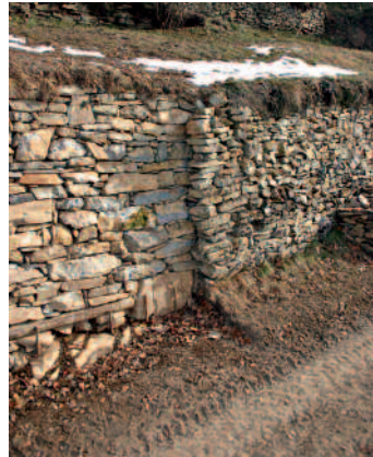
Esempi di non corretto attacco del muro recuperato al muro esistente poiché non viene mantenuto il filo verticale esterno: col tempo questo sfalsamento darà facilmente origine a cedimenti differenziati
