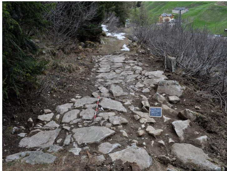
Massicciata stradale evidente sotto il manto erboso nella torbiera.
